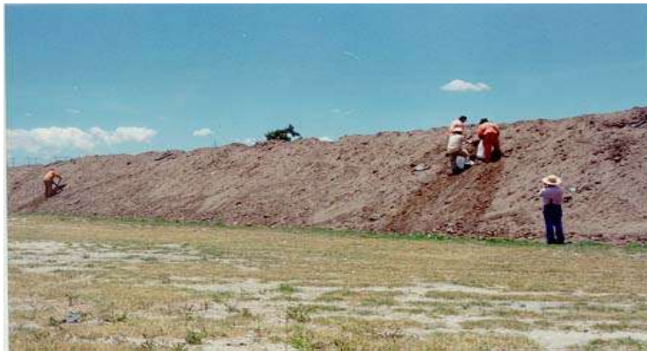
Figura 2. Trabajos de remediación en celdas “ ex situ ” y muestreo de suelo.
